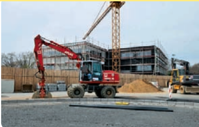
Das Tankdienstgebäude musste in den Betriebs- hof verlegt werden.
