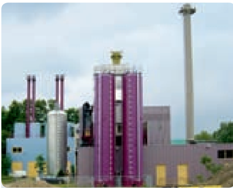
Schon seit 1999 produziert das flughafeneigene Blockheizkraftwerk Wärme, Strom und Kälte.
