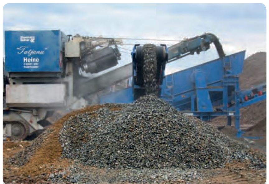
Effektives Recycling: Aus Abbruchmaterial wird Baustoff.
