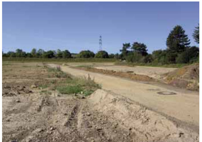
Baugebiet D 15 im September 2012
