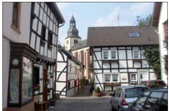
Gut sanierte Fachwerkgebäude an der Teichstraße.
