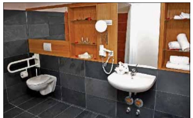
Ein Beispiel für eine Badezimmergestaltung, die kontrastreich, gut ausgeleuchtet und für Rollstuhlfahrer nutzbar ist.
