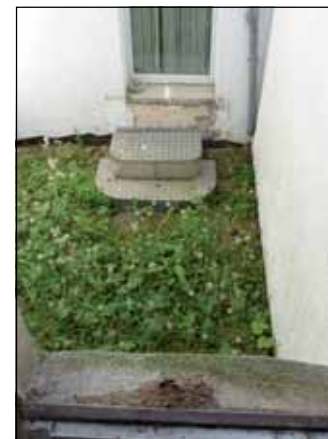
Ausblick Nordwestzimmer in einen kleinen Lichthof.
