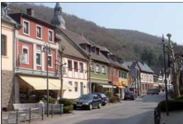
Warme Farben fügen die Gebäude ins Ortsbild ein.
