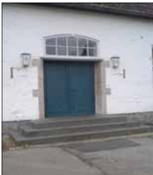
Der Zugang zum Bürgerhaus ist nur über drei Stufen zu erreichen. Es fehlen kontrastreiche Markierungen, Handlauf und ein Zugang über eine Rampe.
