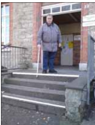
Der Zugang zum Bürgerhaus ist nur über drei Stufen zu erreichen. Es fehlen kontrastreiche Markierungen, Handlauf und ein Zugang über eine Rampe.
