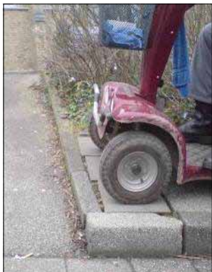
Fehlende Bordsteinabsenkungen erschweren vielen Menschen den Weg.
