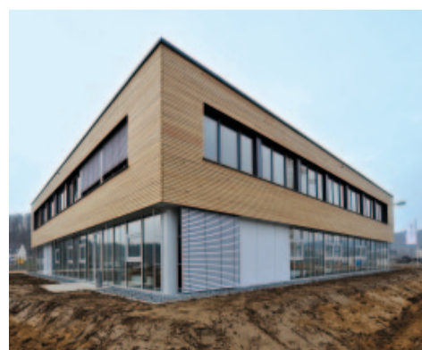
Eine Fassade aus Sibirischer Lärche am Obergeschoss sowie Stahl und Glas im Erdgeschoss prägen das neue Regionalforstamt des Landesbetriebs Wald und Holz. Im Dezember 2010 wurde der Bau fertiggestellt.
