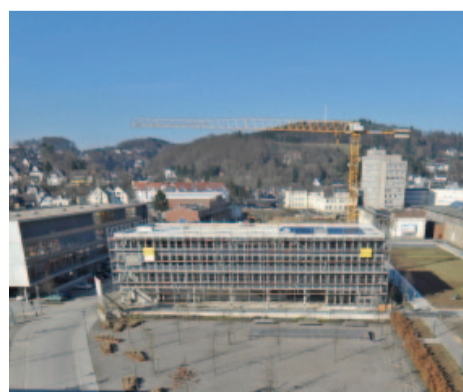
Deutschlands Marktführer im Bereich Engineering-Dienstleistungen investiert in ein vier Stockwerke hohes Bürogebäude. Die neue Firmenzentrale der ABLE Group bietet künftig Platz für 130 Arbeitsplätze.
