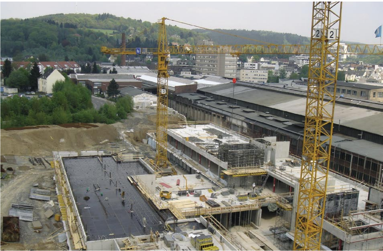
Abbildung unten: Bald ist Richtfest – Der Neubau der Fachhochschule (Gerber Architekten)
