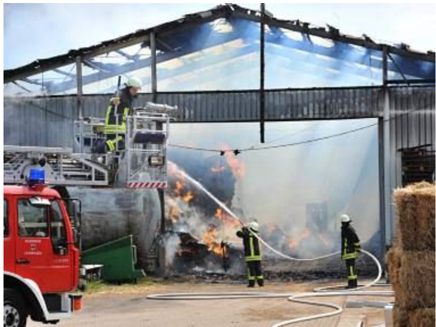
Das komplette Strohlager in einer Industriehalle der früheren Champignonzucht brannte nieder.
