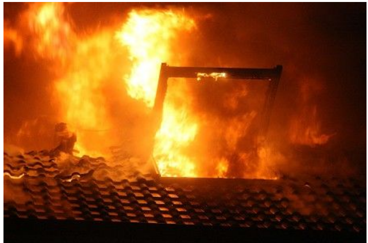
Wie eine Explosion: Als die Feuerwehr am Haus Fichtestraße eintraf und mit dem Löschen begann, brachen die Flammen durch das Dach. Die Nachbarhäuser mussten zeitweise geräumt werden.
