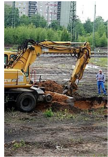
Ein Baggerfahrer entdeckte sie bei Erdarbeiten für Versorgungsleitungen.
