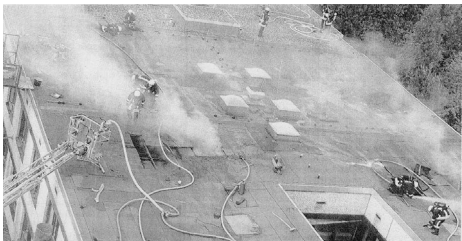
Bei Dachdeckerarbeiten auf einem Gebäude des Seniorenzentrums war Feuer ausgebrochen. Die Feuerwehr suchte nach Brandherden.
