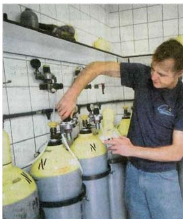
*Klaus Busch im Chlorgaslager am Ventil, das undicht geworden war. 20 Minuten vor dem Alarm waren hier Gasflaschen gewechselt worden.*
