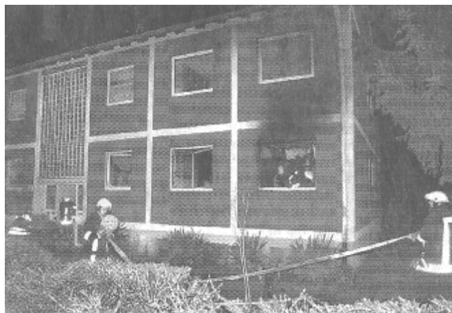
Ein defekter Radiowecker war möglicherweise die Ursache für einen Brand in diesem Haus an der Dünfelder Straße.
