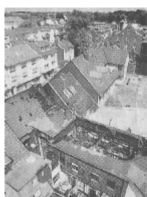
Der Dachstuhl des Opladener Mehrfamilienhauses brannte aus.
