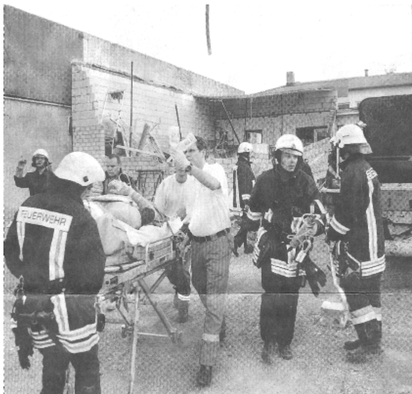
Schwer verletzt wurden zwei Männer ins Krankenhaus transportiert. Beim Bau einer Garage war die Decke eingestürzt (Bildhintergrund). Sie hatte die beiden Bauarbeiter unter sich begraben.
