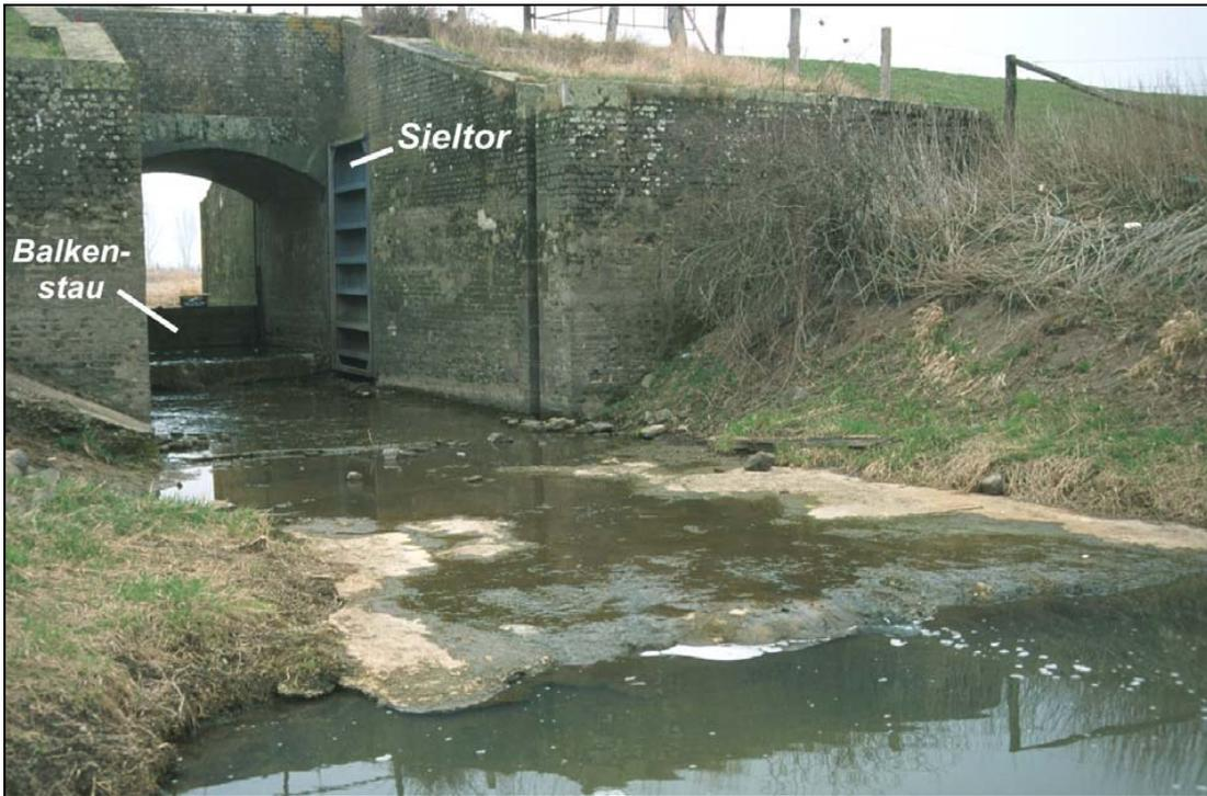
Abbildung 9: Dornicker Schleuse: Weitgehend unpassierbares Siel mit Sieltoren und Balkenstau zur Wasserstandsregulierung des Biener Altrheins (Zustand bis 2001)
