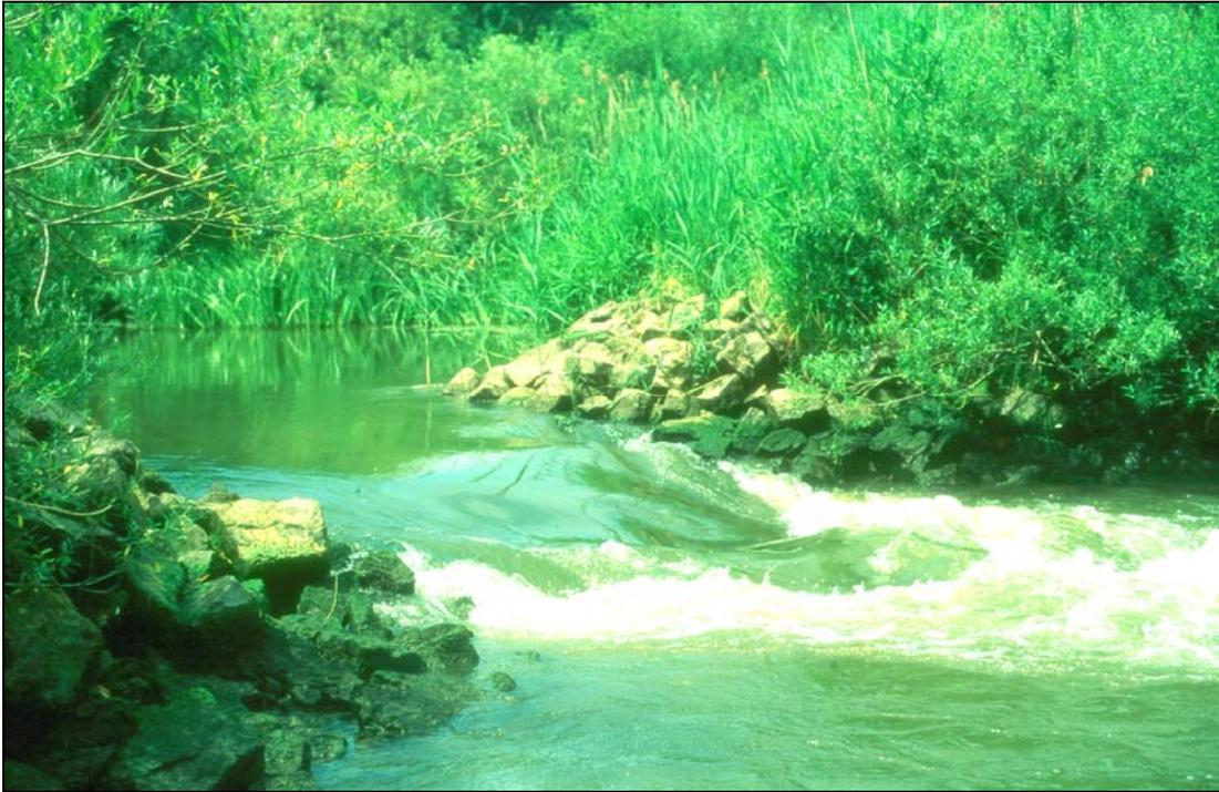
Abbildung 36: Ausströmung von Wasser aus einem Bühnenfeld des Mains bei Vorüberfahrt eines Schiffes
