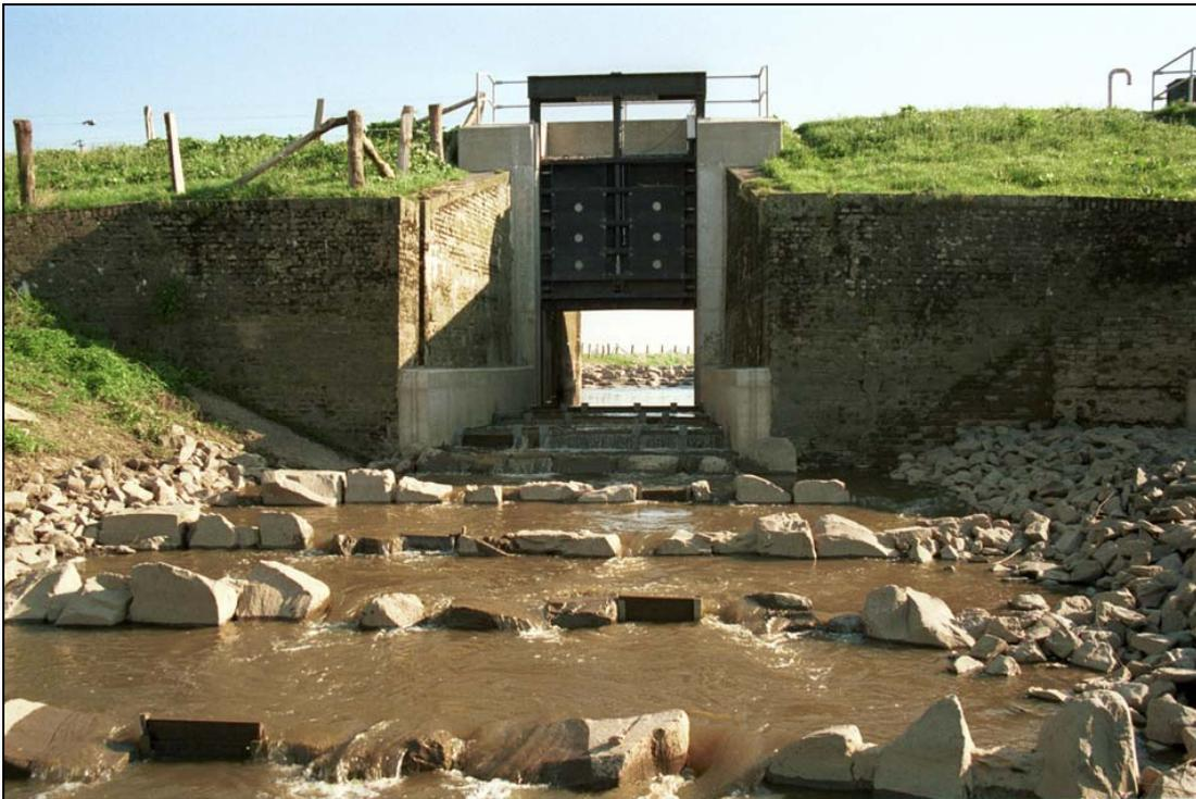
Abbildung 10: Eine Fischaufstiegsanlage an der Dornicker Schleuse ermöglicht seit 2001 Fischwanderungen zwischen dem Fluss und dem Altrhein
