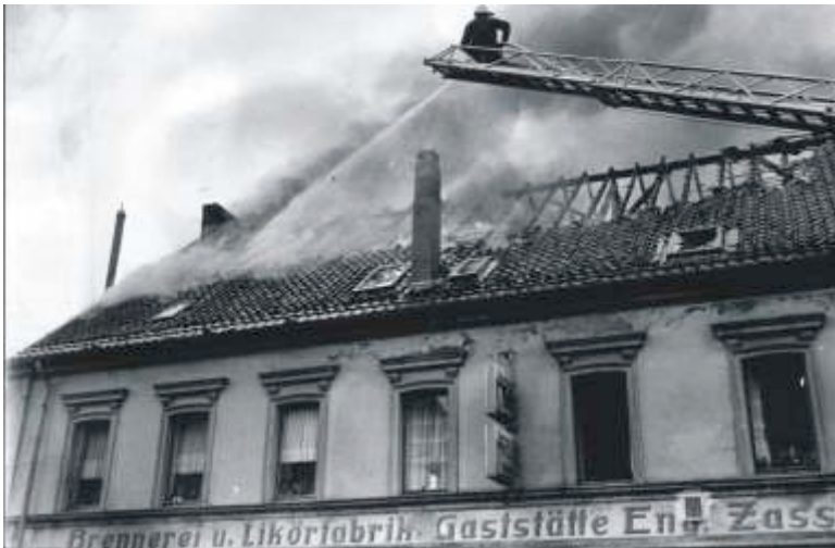
02.12.1972 - Dachstuhlbrand in der Gaststätte Zaß
