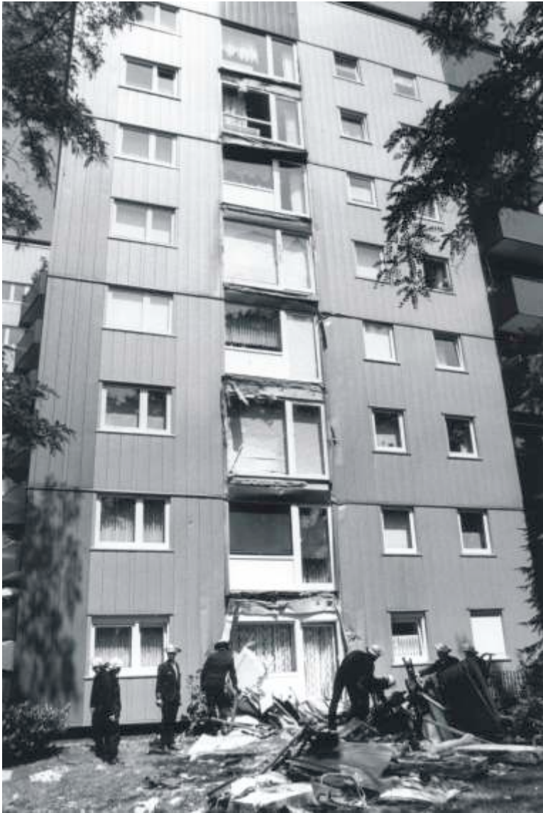
15.06.1992 - Balkonabsturz „In der Adelenhütte“
