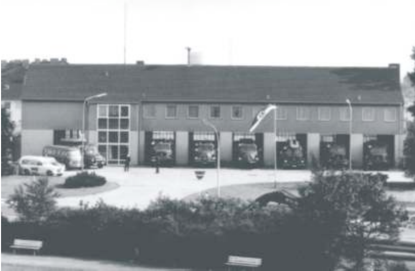
Feuerwache Kaiserstraße 1964 mit kommunalen und LSHD-Fahrzeugen
