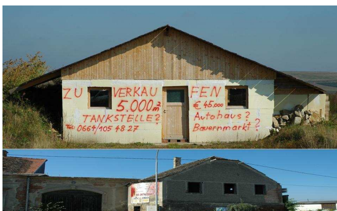
Abbildung 6: Bauruinen in peripheren Abwanderungsgebieten (nördliches Weinviertel)
