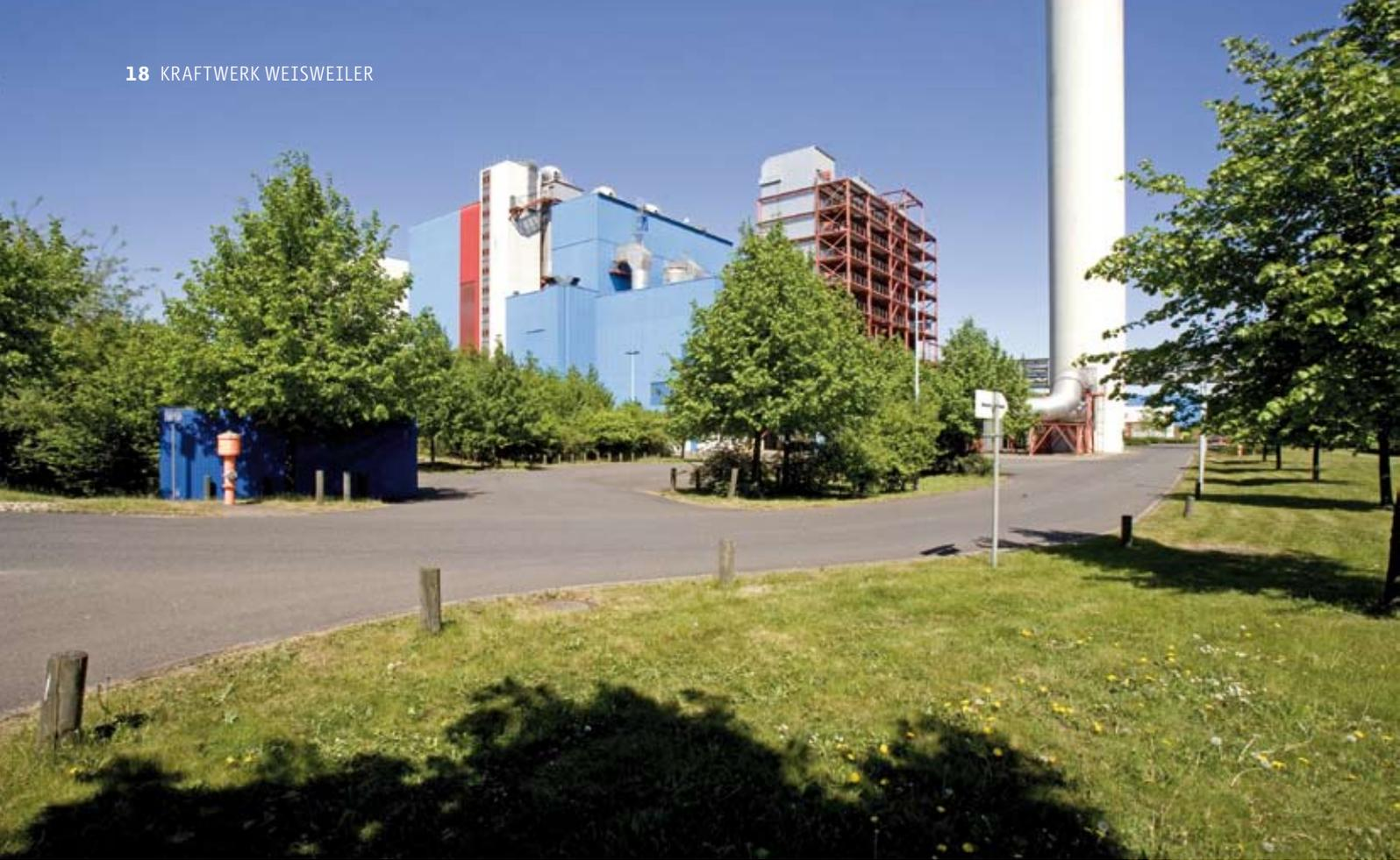
nutzt. Durch die Nutzung der Abwärme der beiden Gasturbinen in den Braunkohlenblöcken G und H kann die elektrische Leistung zusätzlich um je 80 MW gesteigert werden, da der bisher für die Speisewasservorwärmung aus den Turbinen der Braunkohlenblöcke entnommene Dampf zusätzlich für die Stromerzeugung zur Verfügung steht.
