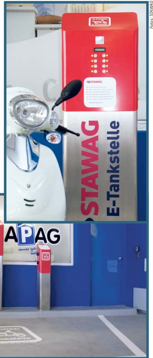
II Die im Roller verbaute Batterie wird über ein Kabel mit normalem Schukostecker aufgeladen. Die Steckdose an der Tanksäule wird durch die Identifikation mit der Tankkarte aktiviert.
