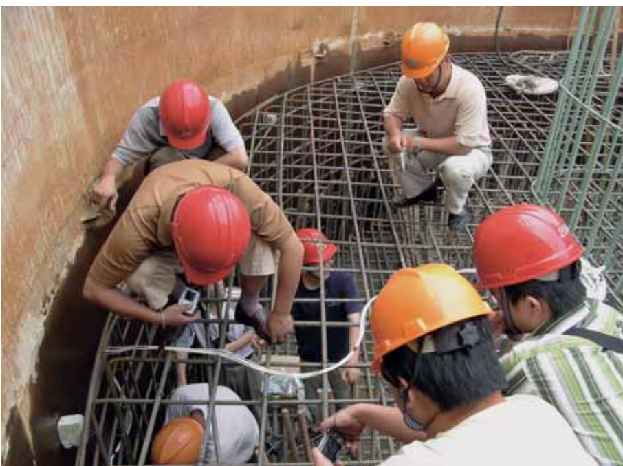
Eine Sensorenleiter wird beim Bau auf dem Stahl angebracht. Damit wird Rostbefall elektrisch gemessen.
