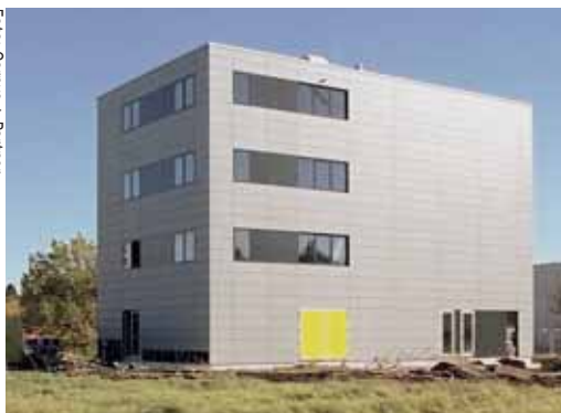
Der erste Bauabschnitt: Das Innotex-Gebäude hat weltweit die erste Fassade aus textilbewehrtem Beton.
