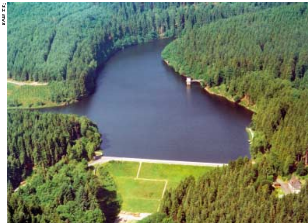
Die Kalltalsperre im Naturpark Eifel dient unter anderem der Energiegewinnung.
