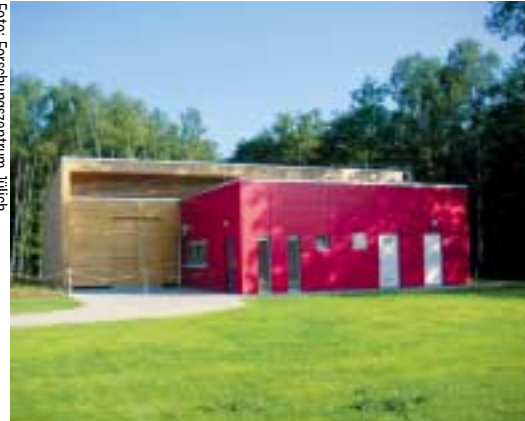
Das neue Gebäude des NMR-Zentrums mit drei leistungsstarken NMR-Spektrometern.
