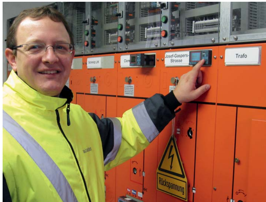
II Spannend: Alliander-Elektrotechniker Stefan Holländer nimmt den „Grid-Supervisor“ in der Kapelle Lieck in Betrieb.
