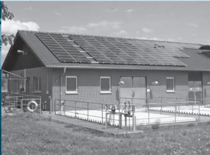
Fotovoltaik als Alternative zur Erhöhung der Eigenerzeugungsquote (Kläranlage Rheinbach)
