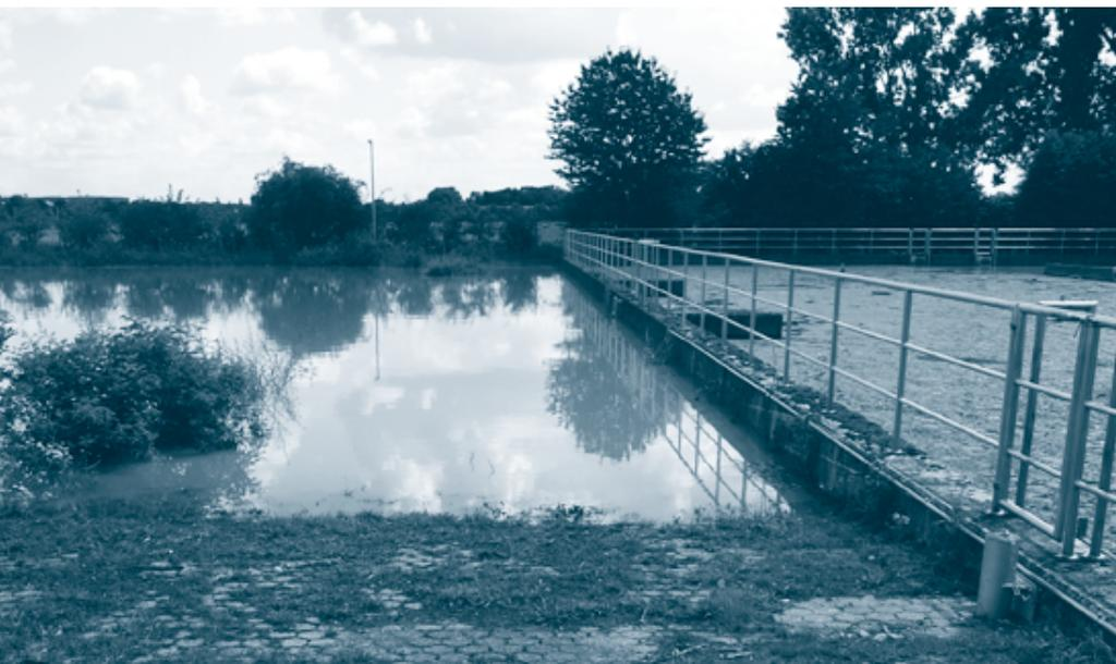
Eingestautes Regenrückhaltebecken auf der Kläranlage Köttingen
