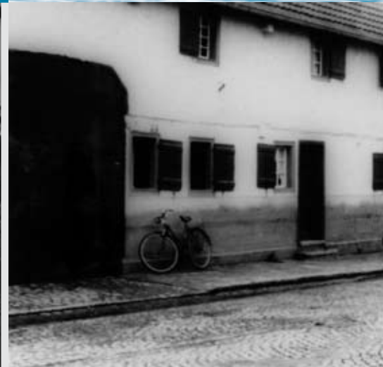
Bliesheim nach dem Hochwasser – sichtbarer Hochwasserstand an den Häusern
