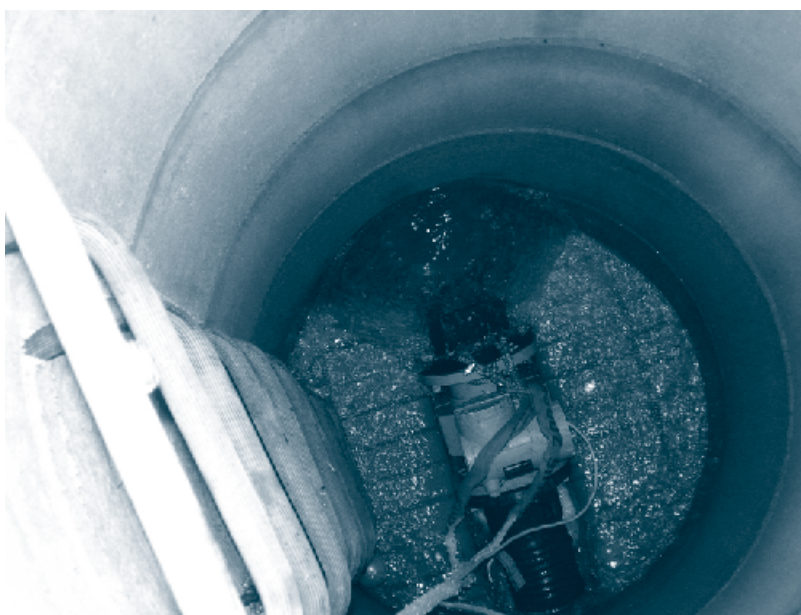
Drosselkalibrierung – Mobiles Messgerät im Einsatz
