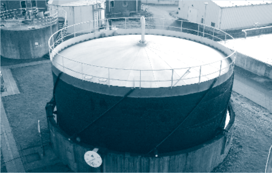
Kläranlage Frechen, Gasbehälter
