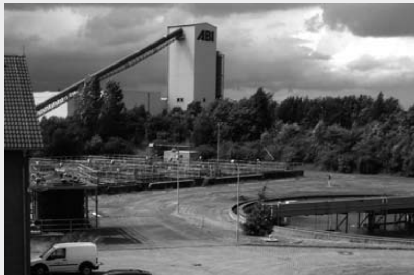
Belebungsbecken und Nachklärung
