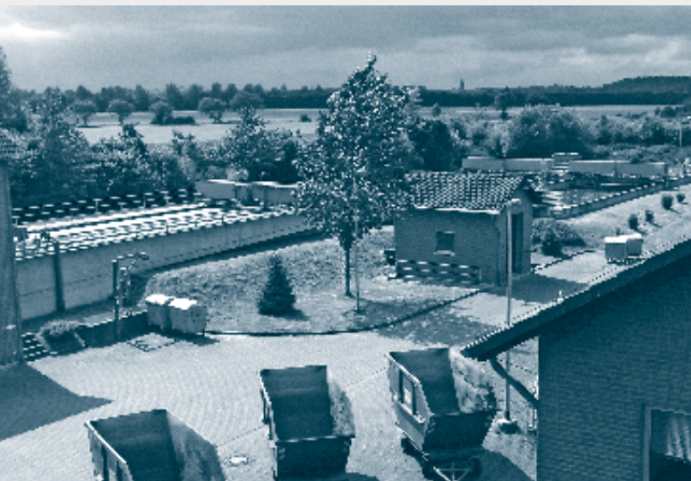
Sammelbehälter für Rechengut, Sandfang und Rückhaltebecken
