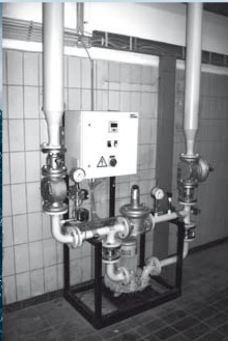
links: Kläranlage Frechen, Faulbehälter (Gashaube) mit Antriebseinheit des Schraubenschauflers rechts: Kläranlage Erftstadt, Gasleitungen im Betriebsgebäude
