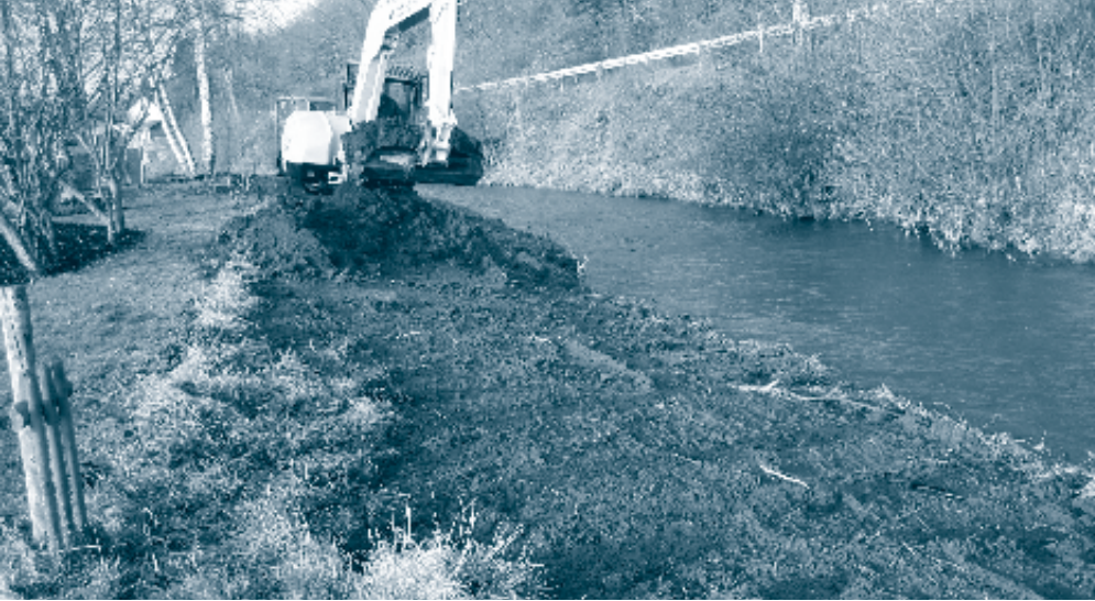
Abflachen der Uferböschung
