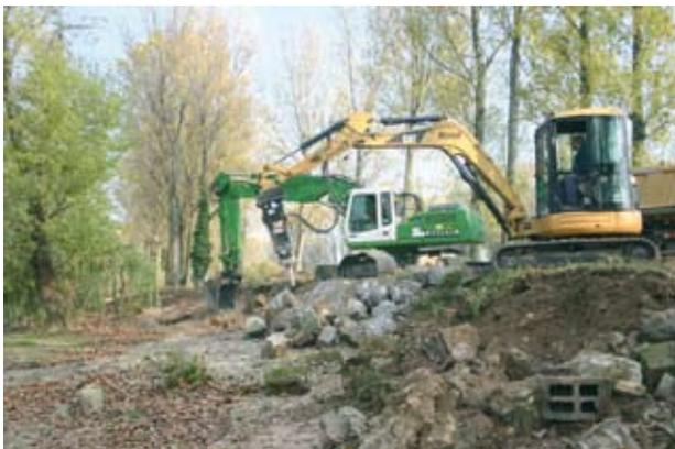
**Baumaßnahme:** Abriss der Ufermauer. Das Projektgebiet liegt vollständig im FFH- und Vogelschutzgebiet. Durch die Maßnahme konnten Entwicklungsziele des Natura 2000-Gebietes – Schaffung naturnaher Ufer als Lebensraum für Schlammuferfluren und flussbegleitende Auwälder – umgesetzt werden.
