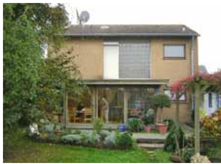
von oben nach unten: Die Bauaufgabe Die Vorfertigung Die Montage, Tag 1
