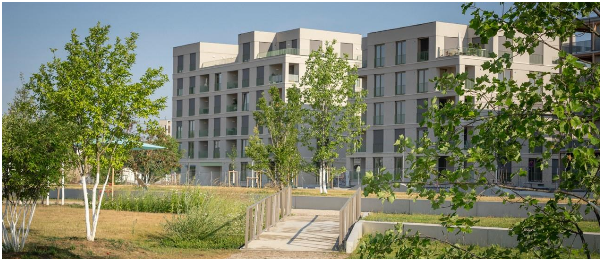
Foto: RADIUS+ Architektur & Baubiologie
