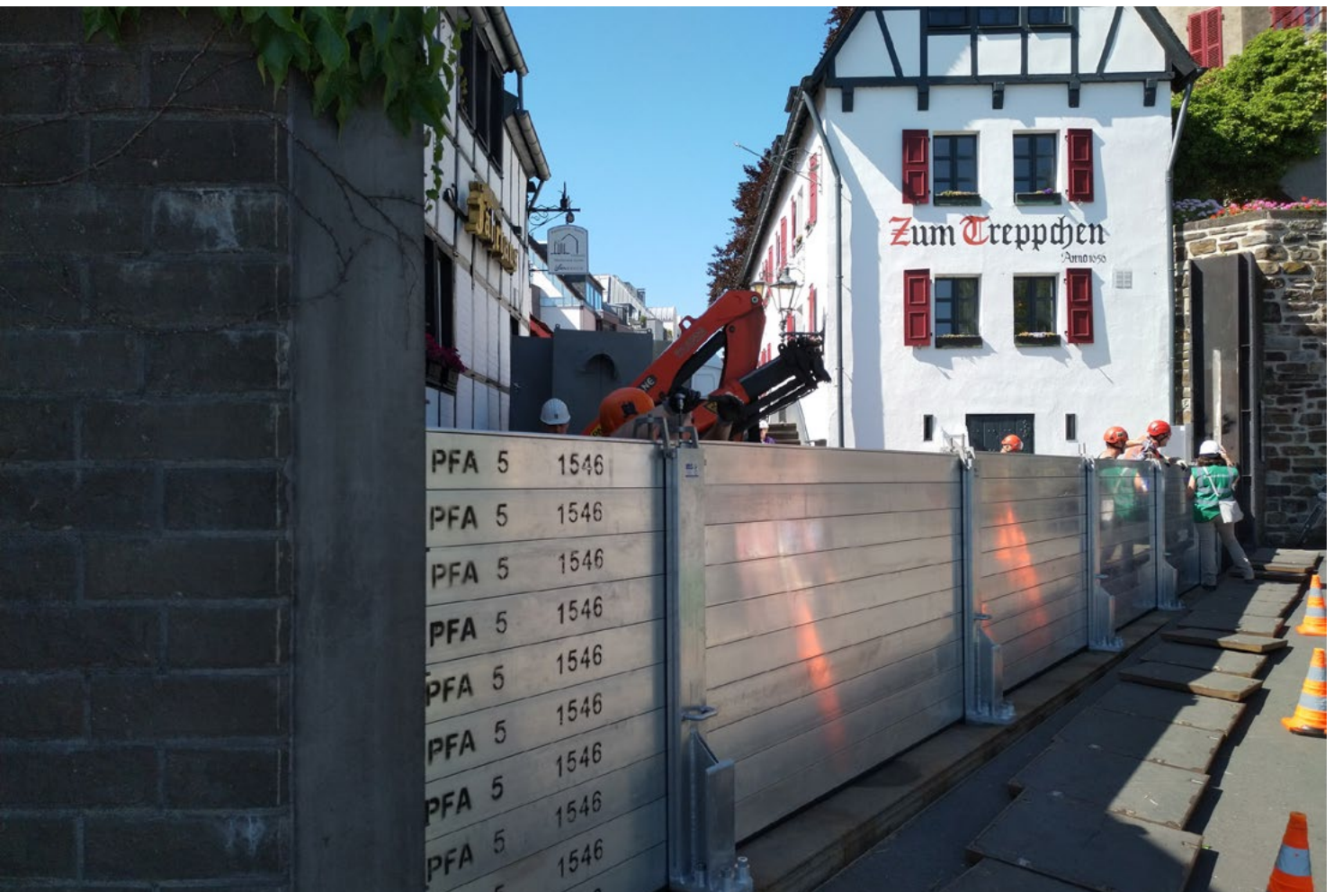
Abb. 45: Aufbau mobile Hochwasserschutz Elemente in Köln-Rodenkirchen
