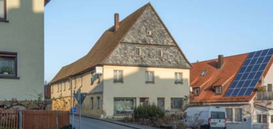
Das denkmalgeschützte ehemalige Gasthaus liegt an einer zentralen Zufahrtsstraße von Thurnau
