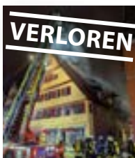
Hotel Luis, Dinkelsbühl (BY): Brand im Oktober 2021, vor 1600, Abriss 2023/24
