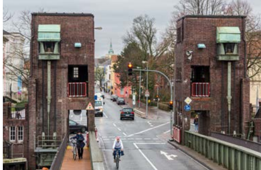
Die Hubtechnik der Cäcilienbrücke war eine technische Pionierleistung
