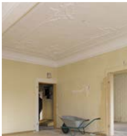
Der Deckenstuck ist gut erhalten
