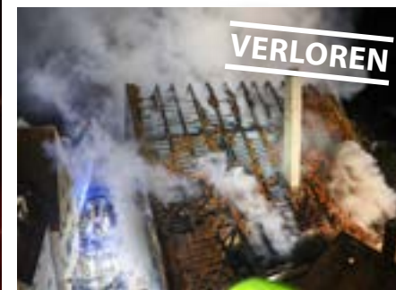
Fachwerkhaus, Riedlingen (BW): Brand im Januar 2025 mit zwei Toten, 2. H. d. 16. Jh., Besonderheit: repräsentatives Fachwerkhaus, historische Stadtmauer aus dem 14. Jh., Abriss 2025
