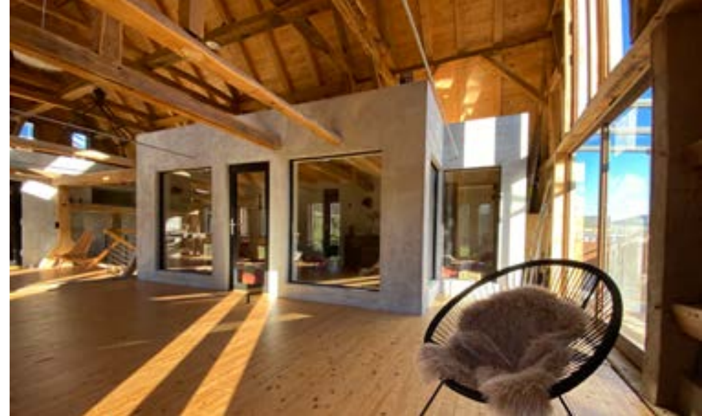
Durch die Haus-in-Haus-Lösung konnte in die Scheune eine Sauna integriert werden, ohne dass die Originalsubstanz Schaden nimmt
