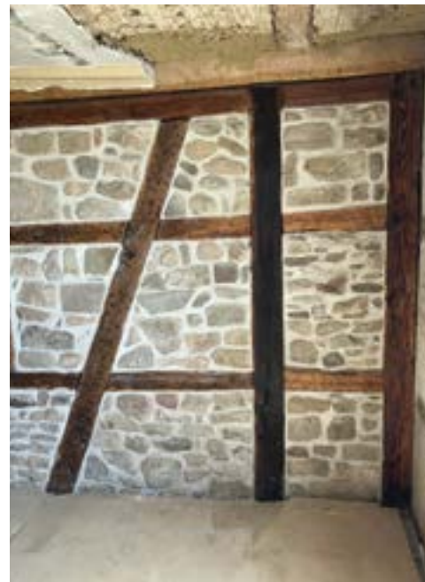
Eine sanierte Fachwerkwand ist mit Steinen ausgefacht
