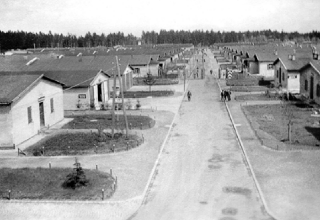
Im Zweiten Weltkrieg war das Stalag VII A das größte Kriegsgefangenenlager der Wehrmacht in Süddeutschland. Blick vom Wachturm am Haupteingang auf die Hauptstraße des Lagers
