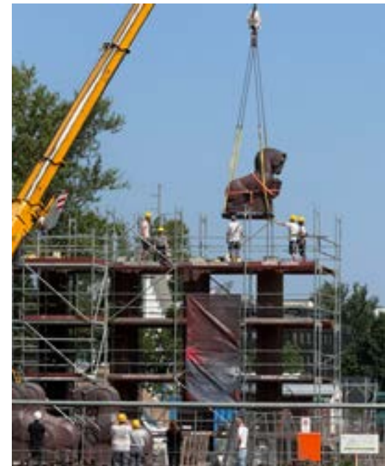
Im Juli 2026 wurden die Pferde per Kran wieder auf die Säulen gesetzt
