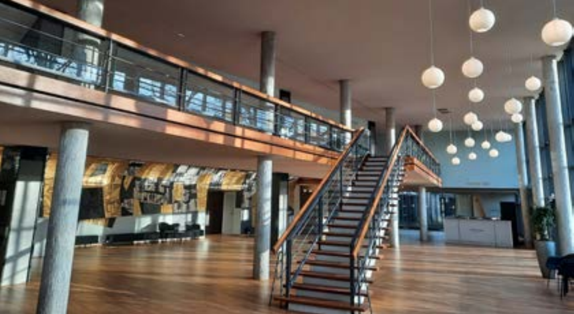
Im Foyer wurde die originale Ausstattung aufgearbeitet und wiederverwendet
