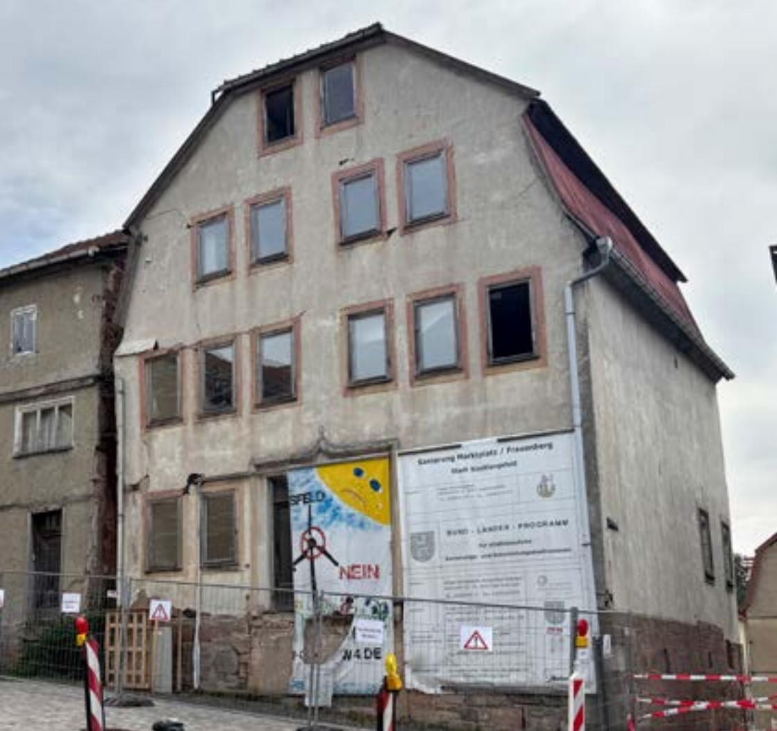
Die ehemalige Freitreppe wurde bereits in den 2010er Jahren entfernt und sollte eingelagert werden. Doch auch sie ist verloren, da sie nicht mehr auffindbar ist.
