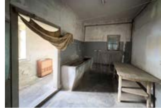
In den Wachmannschaftsbaracken wird Zeitschicht sichtbar: Aus der Zeit als Kriegsgefangenenlager stammt z. B. dieses Waschbecken
