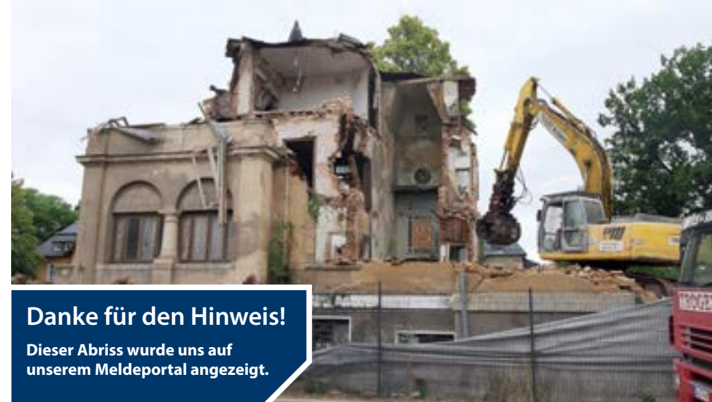
Im Frühjahr 2025 wurde die Ulrich-Villa abgerissen
