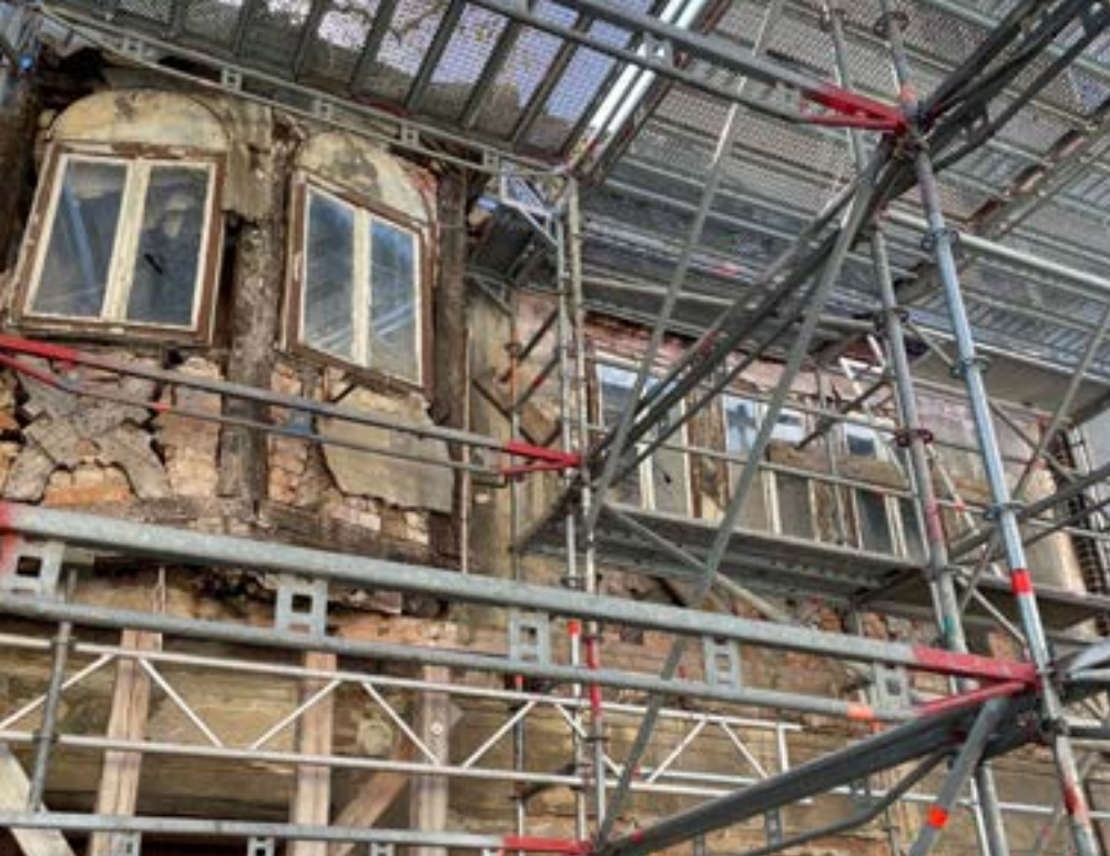
Das vernachlässigte Gebäude wurde in einer Sicherungsmaßnahme abgestützt
