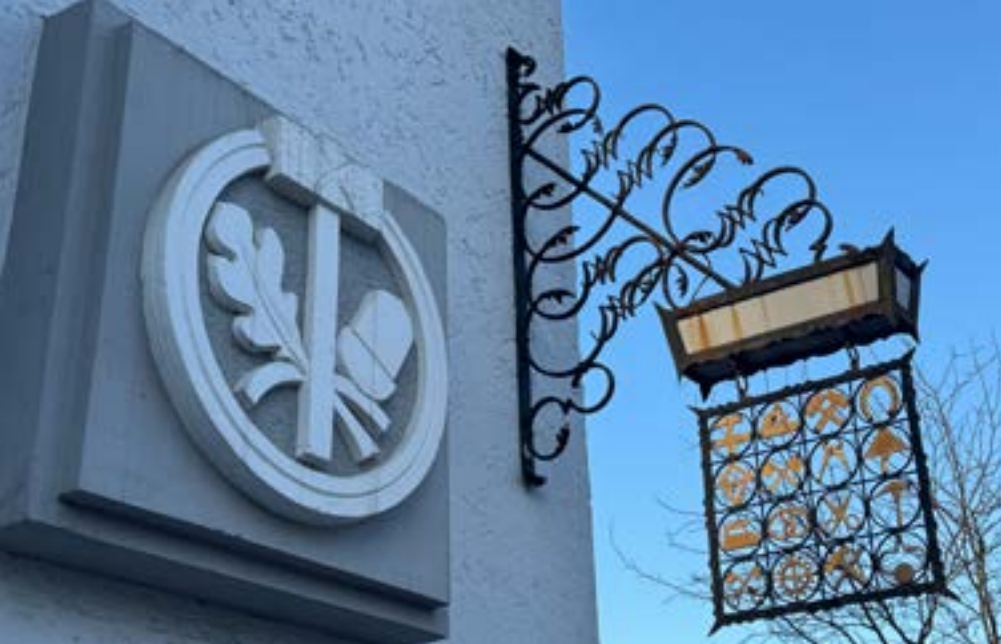
Schmuckdetails an der Fassade des Ergänzungsbaus von 1937
