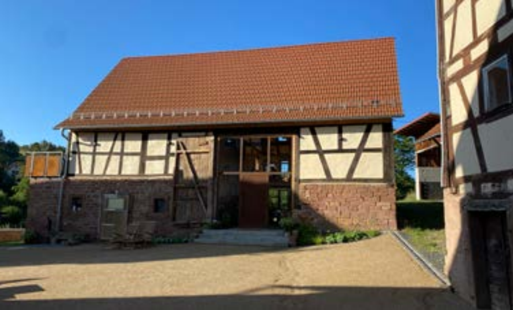
Das für die Scheune charakteristische große Tor prägt auch nach der Sanierung das Denkmal
