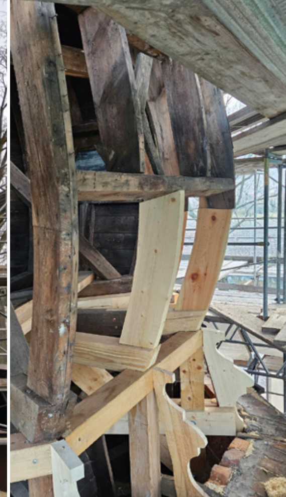
Instandsetzung der Dachkonstruktion
