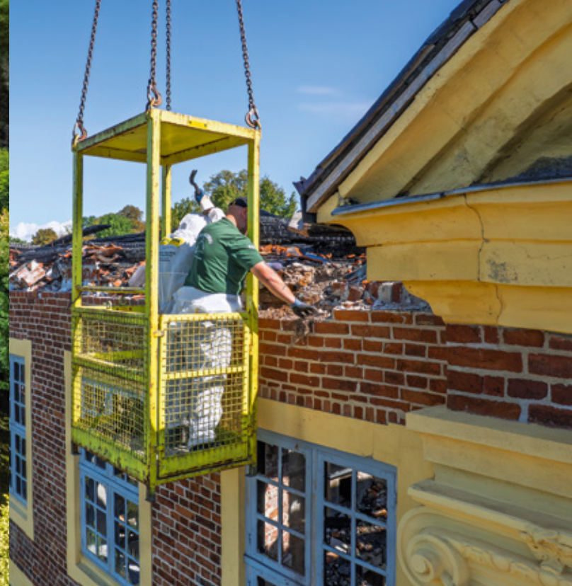
Von links nach rechts und oben nach unten: Vorbereitung der Notsicherung „von oben“; das Schloss vor dem Brand; Teile der erhaltenen Stuckausstattung; Innenraum mit Notdach
