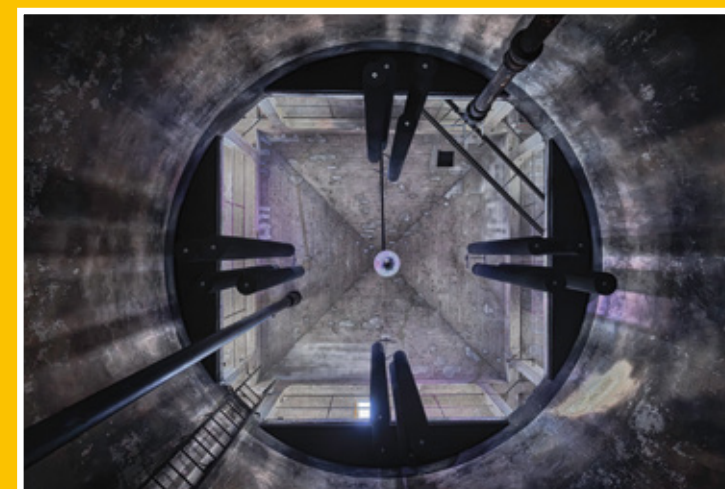
Platz 2: Peter Dammert, ehemaliger Tankturm in Heidelberg
