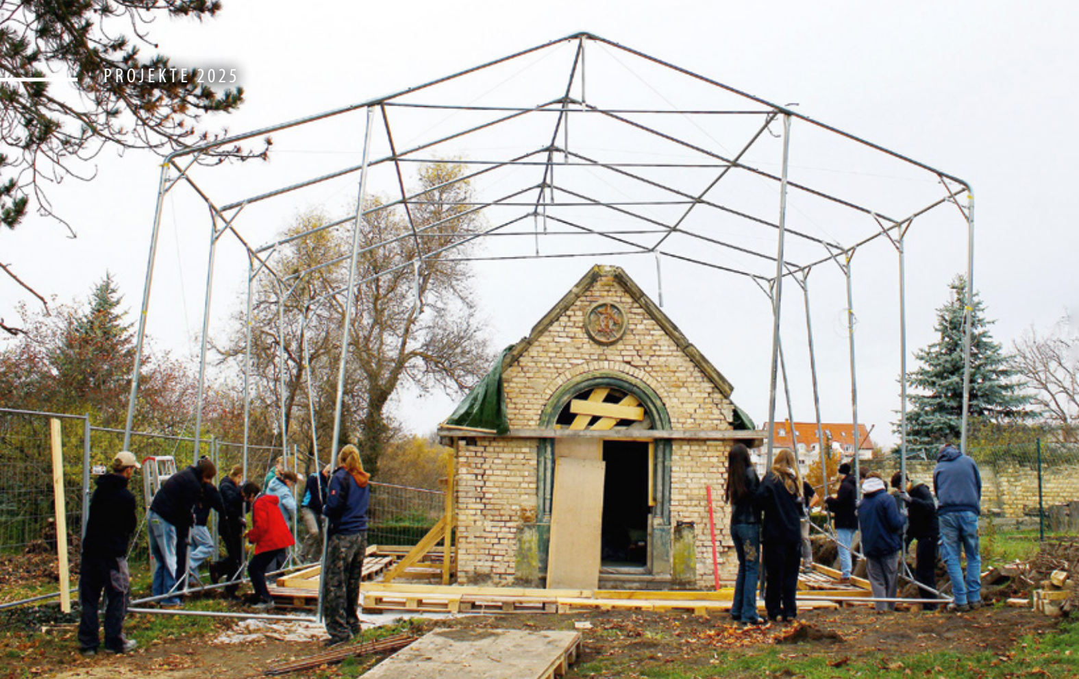
Beim Aufstellen der Einhausung vor der Instandsetzung des Sinti-Mausoleums durch Schülerinnen und Schüler des Elisabeth-Gymnasiums in Halle (Saale)
