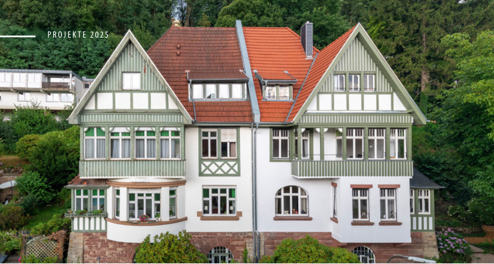
Ansicht des Doppelhauses von der Straßenseite. Die Deutsche Stiftung Denkmalschutz unterstützte Familie Fuchs bei der Instandsetzung der rechten Haushälfte.
