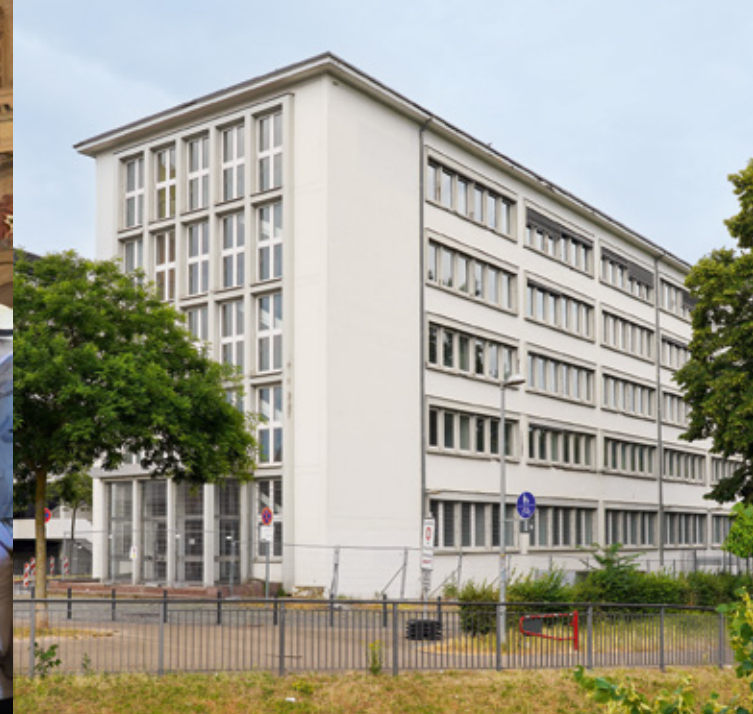
Das ehem. Finanzamt in Saarbrücken
