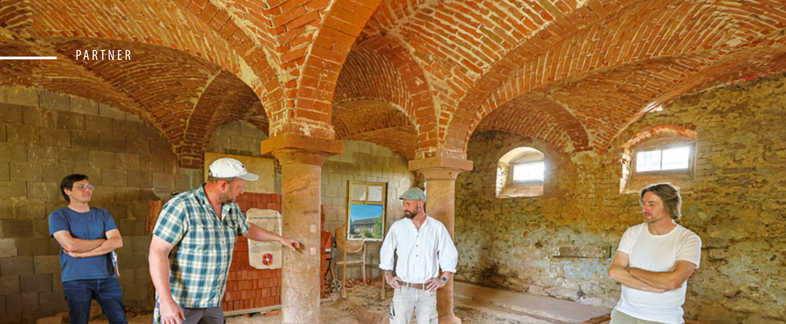
Auf der historischen Hofanlage in Nobitz-Kleinmecka gingen die Arbeiten in 2025 weiter – erneut unterstützt von der Deutschen Stiftung Denkmalschutz
