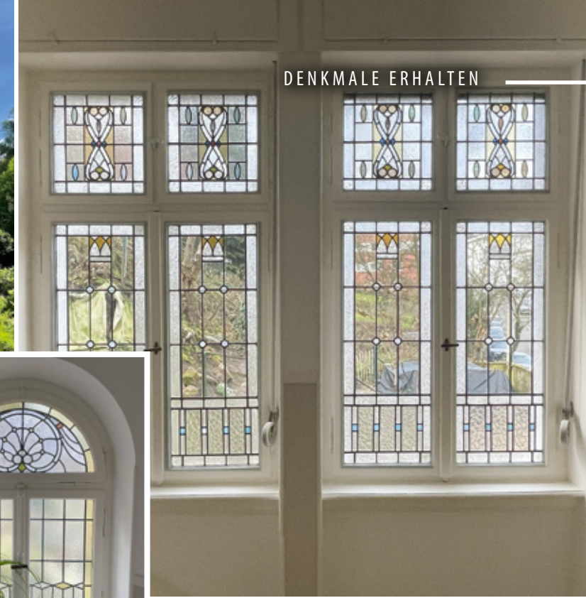
Einige der restaurierten Fenster
