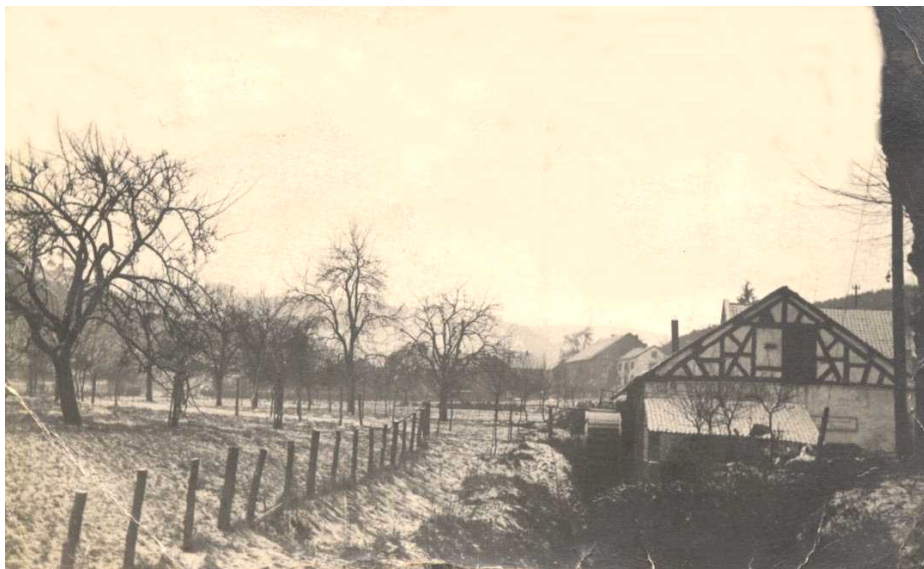
„Alter Hammer“ bzw. Schmiedebetrieb des M. Theisgen Eiserfey gegen Ende der 1930er Jahre. An der linken Gebäudeseite ist das Wasserrad noch gut sichtbar.
