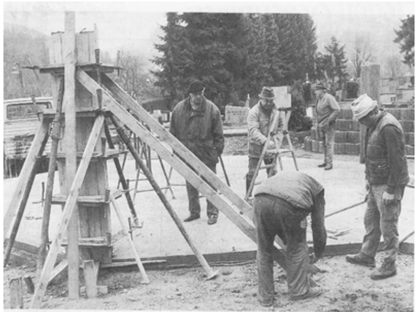
Am Freitag der letzten Märzwoche arbeitet eine Gruppe von freiwilligen Helfern nach Feierabend an der Baustelle der neuen Leichenhalle. (Bilder: Günter Zumbé)
