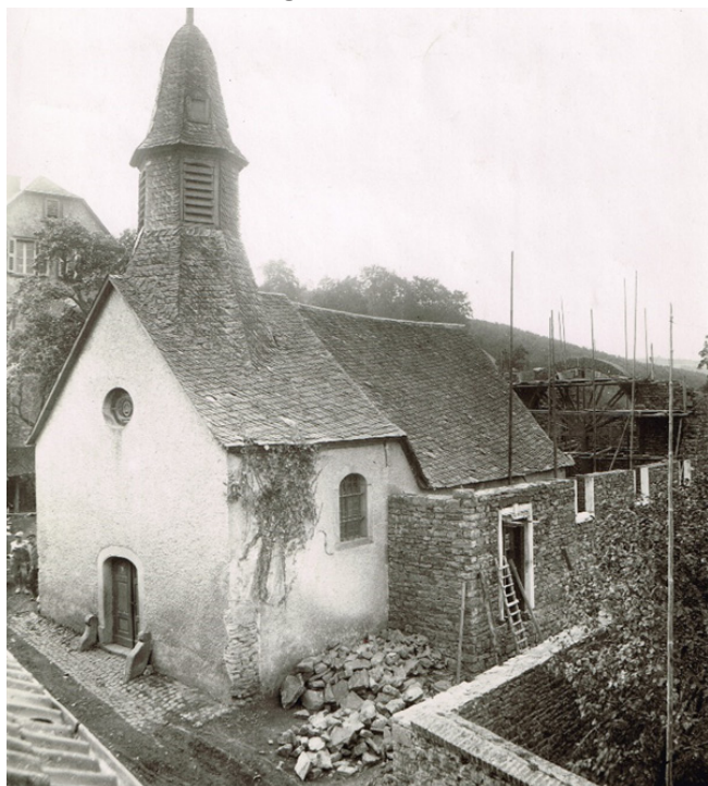
Kirche im Rohbau 1934
