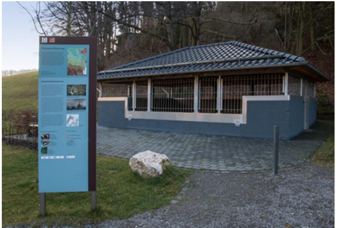
Brunnenstube Kallmuth nach der Fertigstellung
