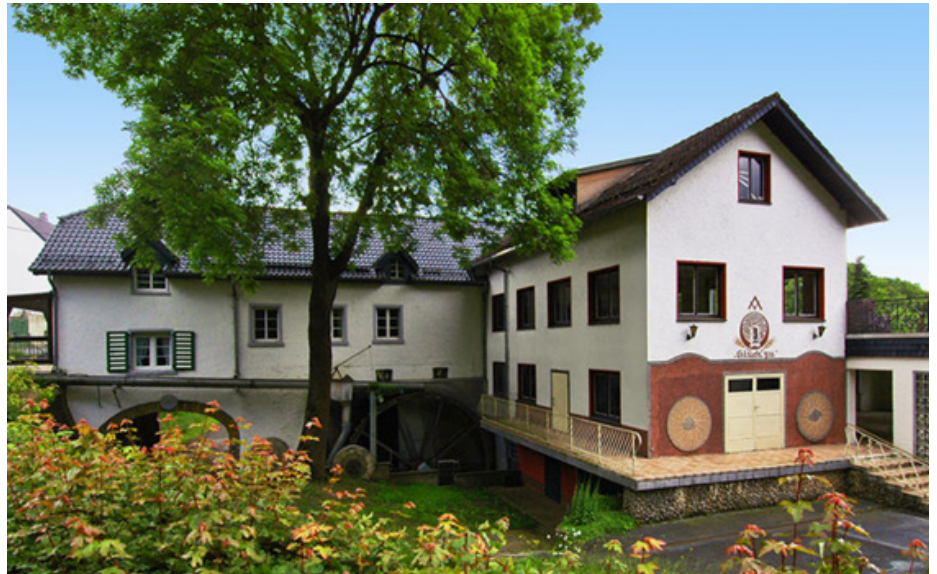
Die Mühle Giesen in Dreimühlen
