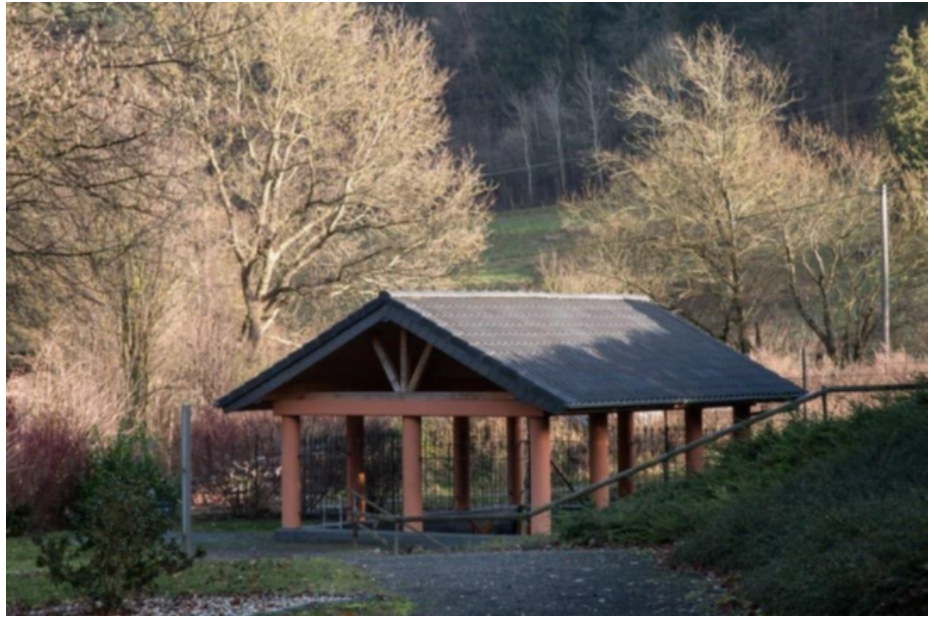
Kleine Aquäduktbrücke mit Schutzbau nach der Fertigstellung
