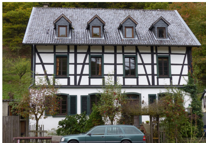
Das einst zur Pulverfabrik gehörende Verwalterhaus an der B477
