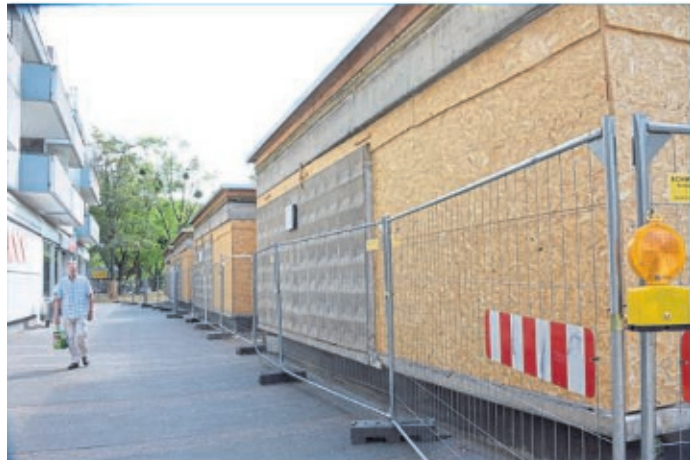
Gebaut wird vor Ort zunächst nicht mehr. Foto: Rahmann
