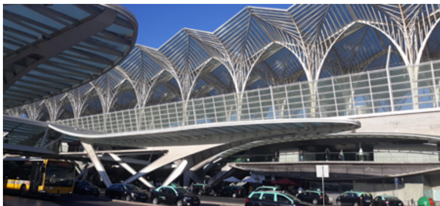
Hauptbahnhof Lissabon, Architekt Calatrava.
