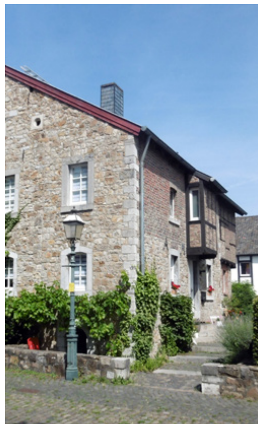
Ein denkmalgeschütztes Haus in der Brander Buschstraße.
