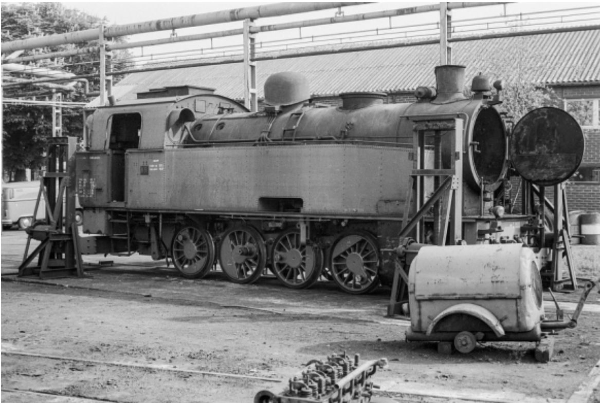
Bild 2: Für die Unterhaltung der Dampfloks war die Maschinenhauptwerkstatt des EBV in Mariendorf zuständig. Am 1.6.1984 war hier Lok Anna Nr. 5 in Arbeit. Foto: Pinguin Moschner
