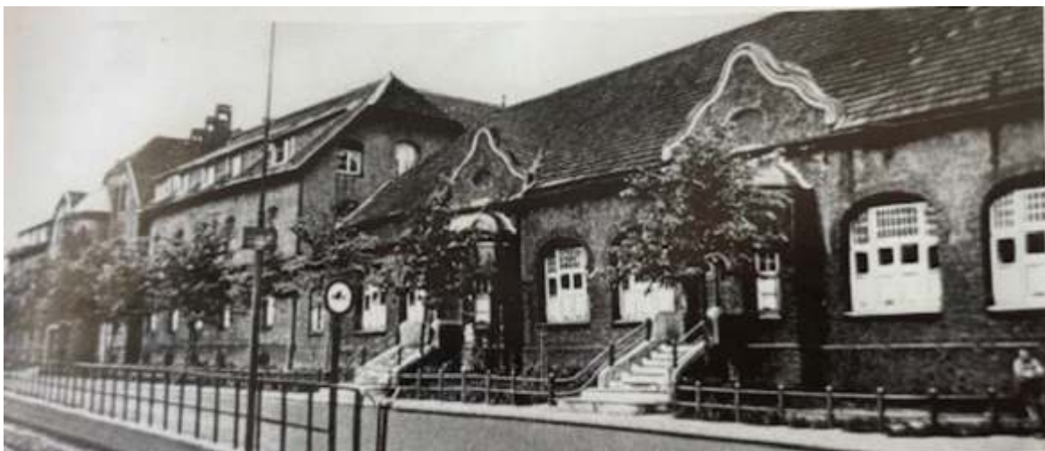
Vorderfront mit dem Verbindungsbau zwischen Ledigenwohnheim und Kantine
