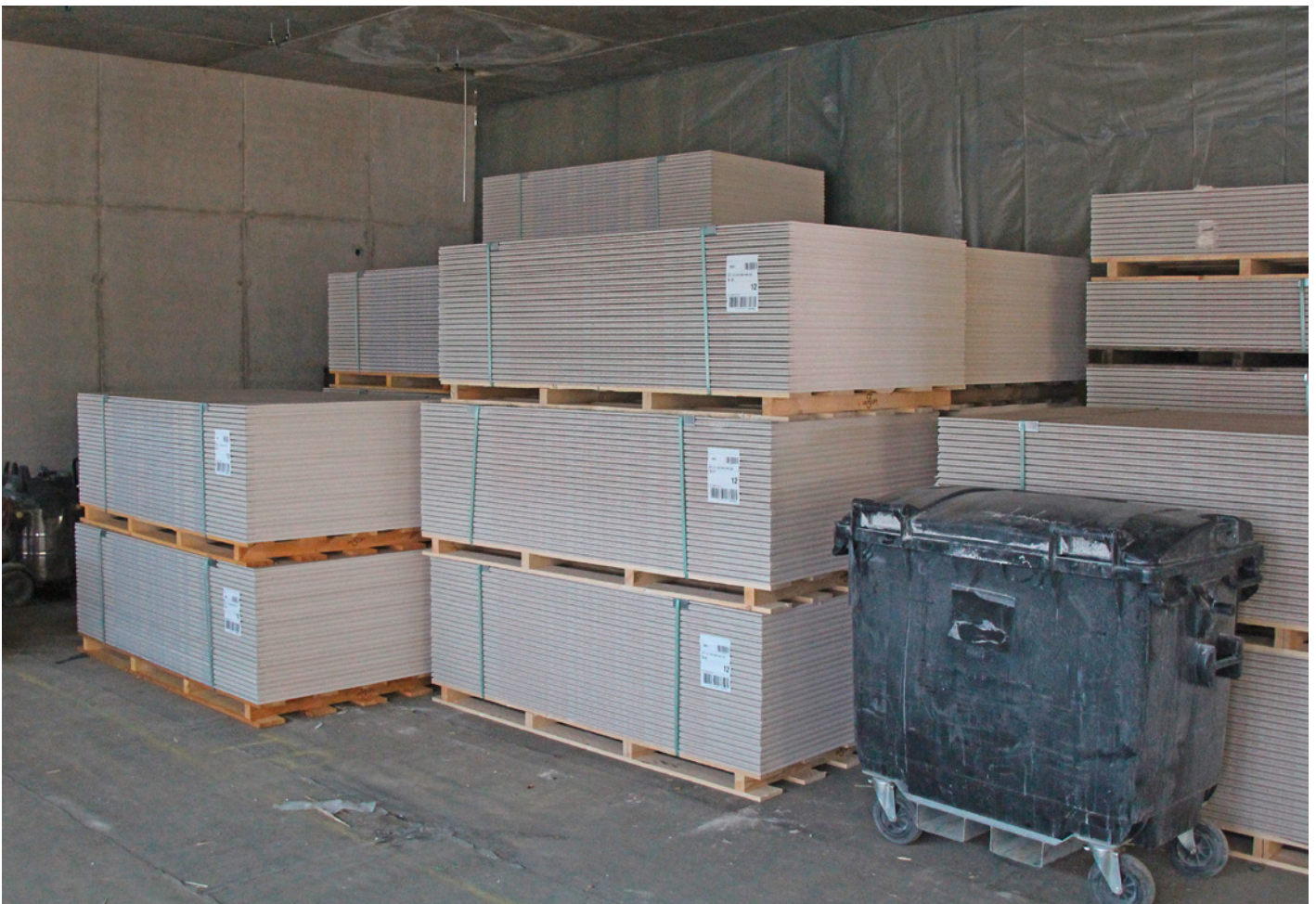
Abb. 9: Lagerung von Trockenbaumaterialien; Quelle: Technische Universität Braunschweig, Institut für Bauwirtschaft und Baubetrieb
