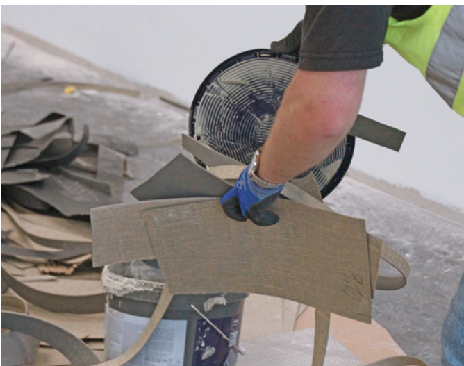
Abb. 8: Verwiegung von Verschnittabfällen am Einbaort; Quelle: Technische Universität Braunschweig, Institut für Bauwirtschaft und Baubetrieb
