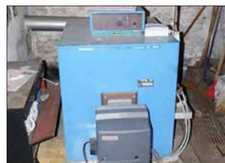
Beispiel Ölheizkessel Ende der 1980er-Jahre
