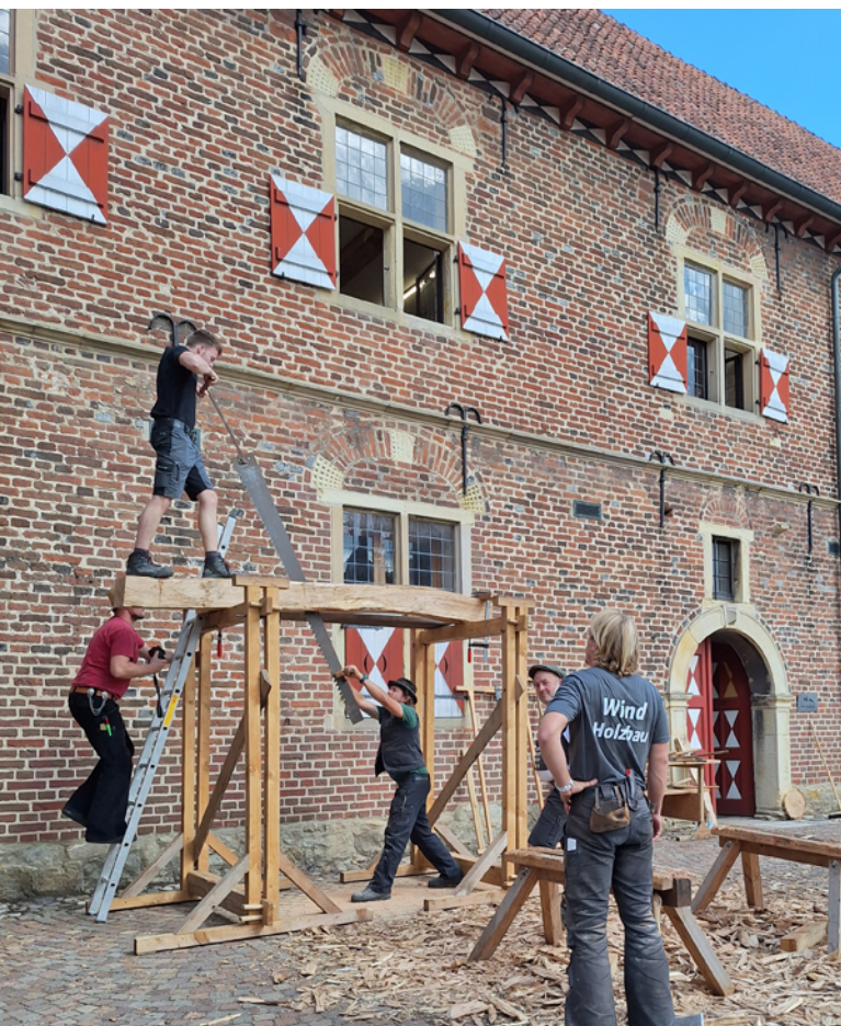
Übungen der Zimmerleute zum Sägen und Bebeilen von eichenen Holzbalken in der Akademie Schloss Raesfeld
