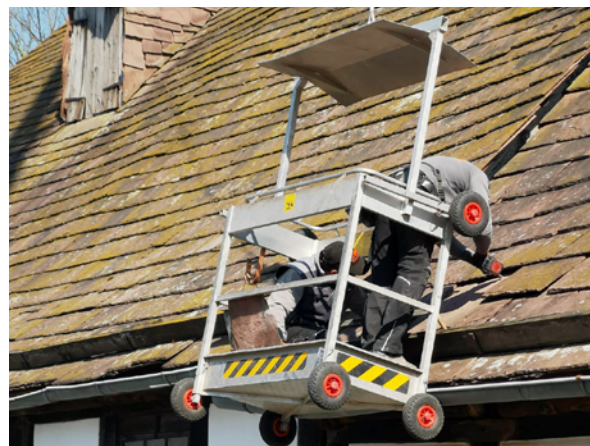
Reparatur an einem mit Sandstein gedeckten Dach
