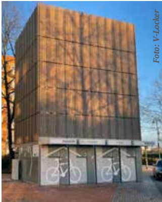
Das Fahrradparkhaus vor dem Beueler Bahnhof
