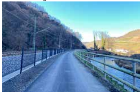
Der Ahr-Radweg bei Marienthal: Hier wird deutlich, wie eng der Ahr-Radweg mit der DB und dem Flusslauf verbunden ist.
