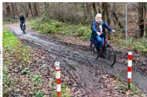
Tiefe Schlammrinnen, eine Zumutung für alle Radelnden
