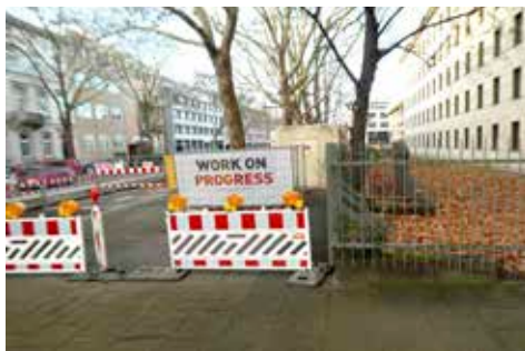
Zu breit macht sich hier die Baustelle.
