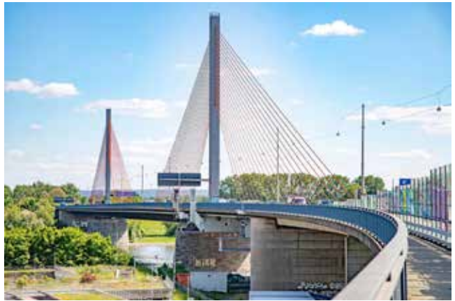
Auf der Nordbrücke, die neu gebaut werden muss, weigert sich die Autobahn GmbH, einen Radschnellweg zu bauen – anders als in Duisburg. Dabei ist die Brücke auch eine wichtige Rheinquerung für den Radverkehr.
