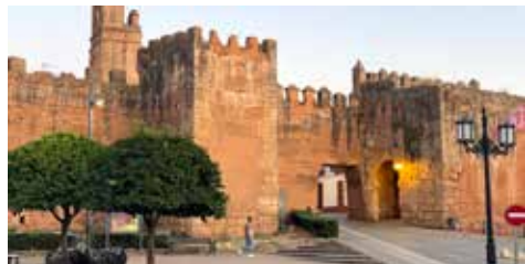
Stadtmauer von Niebla aus der Zeit der Mauren
