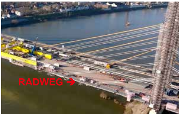
Aktuelles Bild der A40-Rheinbrücke in Duisburg: Gut zu sehen ist im Vordergrund der vier Meter breite Radschnellweg neben der Fahrbahn.
