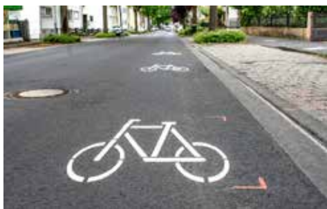
Erstmals in Bonn sind auf der Pützchens Chaussee in Beuel Piktogrammketten aufgebracht worden, um die Sicherheit der Radfahrer zu erhöhen.
