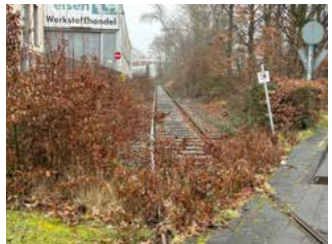
Die Trasse der nicht genutzten Bahnstrecke zwischen Beuel und Hangelar wäre ideal für eine Radpendlerroute zwischen Sankt Augustin und dem Beueler Zentrum.
