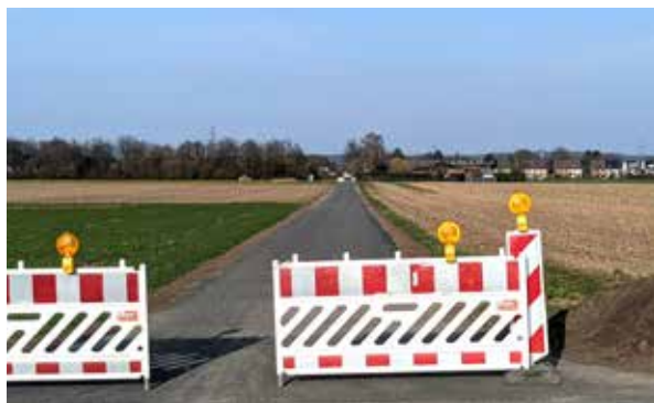
Die Asphaltierung der verlängerten Südstraße verbessert die Erreichbarkeit der S-Bahn-Station Spich
