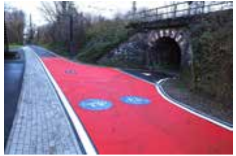
Die Poller mitten auf dem Radweg am Oberkasseler Ruderhaus sind verschwunden, die Gefahrenstelle am Abzweig auffallend markiert.
