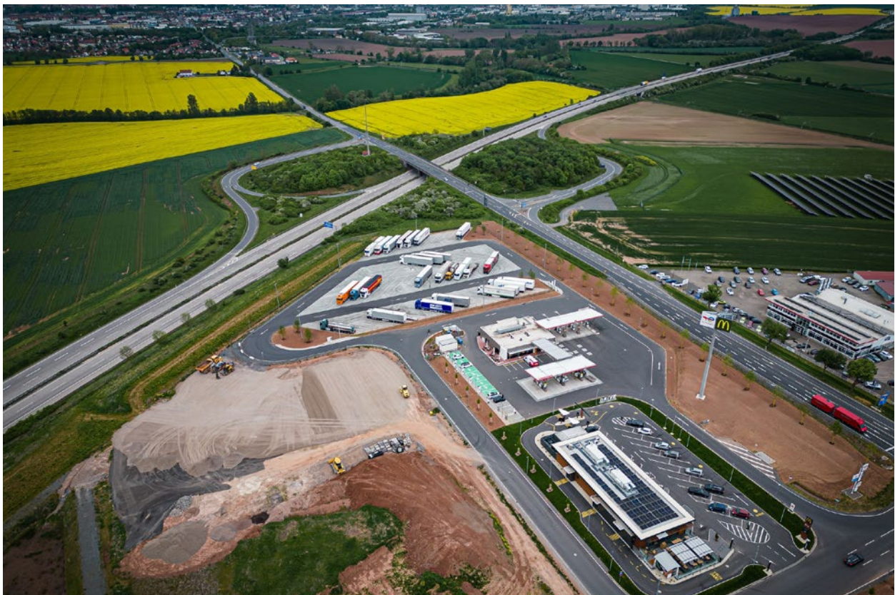
Geförderter Neubau eines Parkplatzes mit 54 Lkw-Stellplätzen an der A 38 (Anschlussstelle 10 Nordhausen-West).
