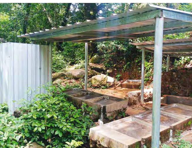
An der Wasserquelle wurden überdachte Waschmöglichkeiten errichtet.
