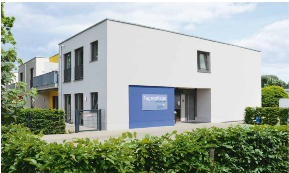
Tagespflege in unserem Neubauobjekt Ruwerstraße, Erftstadt-Gymnich
